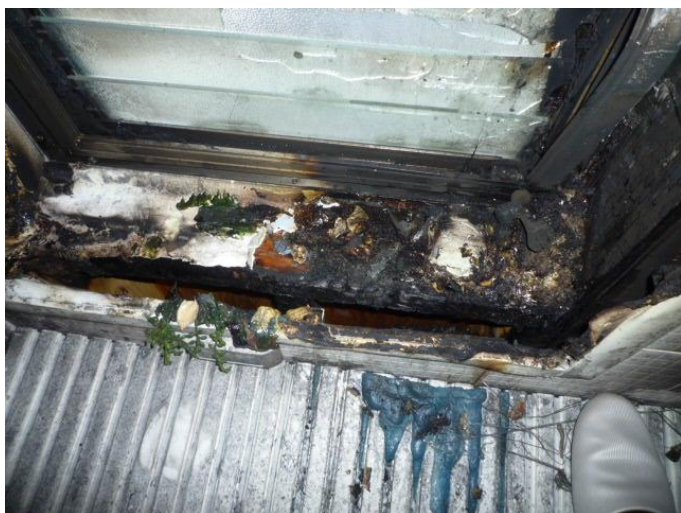
アップルゲートの防火性能で構造材の延焼防止
