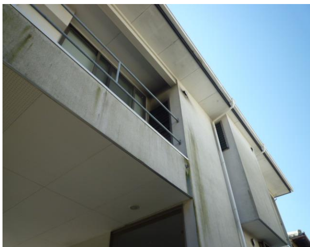
樹脂窓枠が溶けて木枠、ジャロジ窓延焼後
